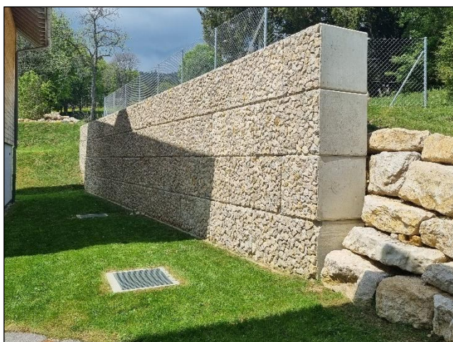
Blocs en béton avec empierrement d'une face latérale
