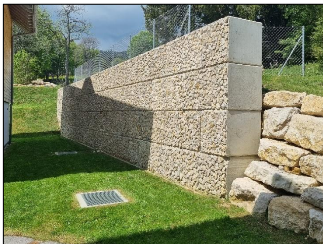
Blocs en béton avec empièchement d'une face latérale
